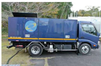
電源車、体育館に横付け駐車
