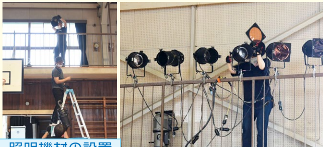
照明機材の設置
